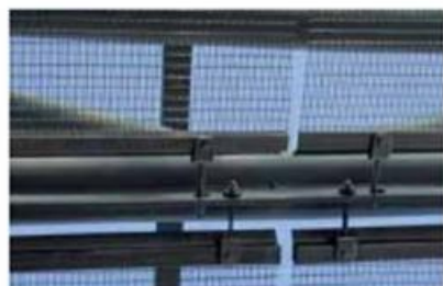
Szőtt drótháló elemek feszítőprofilal és clevis csavarrendszerrel kifeszítve.
