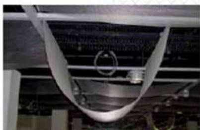
Hornyos profilokkal szegett drótháló elem nyitott állapotban.
