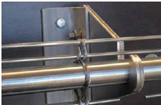
Felső rögzítés: kerek támogató rúd háromszög alakú konzolba építve (Szövet típusa: MULTI-BARRETTE)
