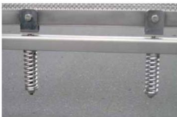
Középső rögzítés: Drót csatlakoztató
