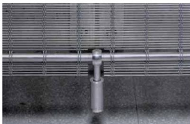
Középső rögzítés: Kerek rúd beépített, háromszög alakú konzolhoz csatlakoztatott függő rögzítő lemezekkel (Szövet típusa: MULTI-BARRETTE)
