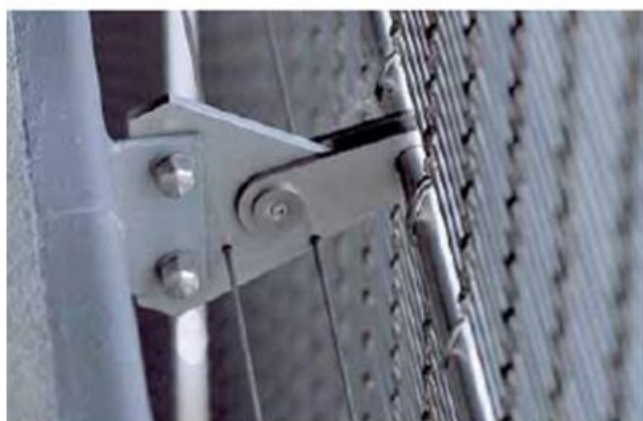
Középső rögzítés: Kerek rúd beépített, háromszög alakú konzolhoz csatlakoztatott függő rögzítő lemezekkel (Szövet típusa: MULTI-BARRETTE)
