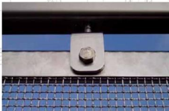
Felső rögzítés: feszítő profil és clevis csavar
